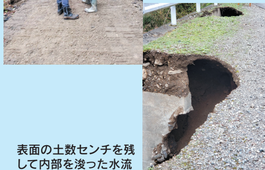
急傾斜地保護の分厚いコンクリート擁壁を破壊して流れ込む土砂
