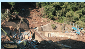
急傾斜地保護の分厚いコンクリート擁壁を破壊して流れ込む土砂
