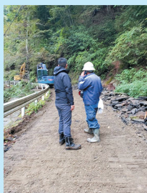
被災地の復旧状況を確認
